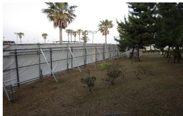
施工例1(くい丸打込)
